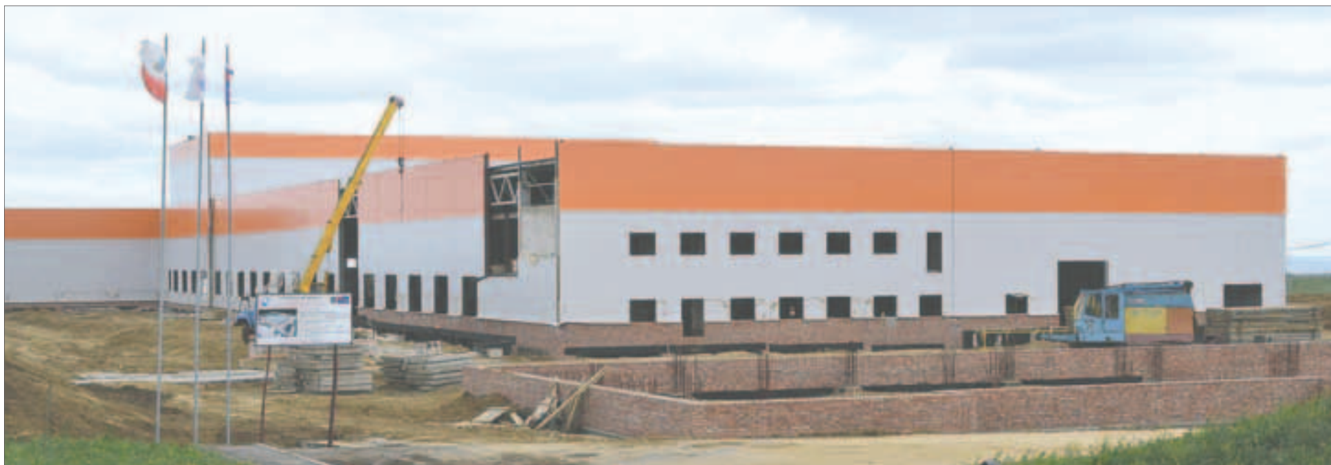
Здание построено. На очереди – монтаж оборудования
